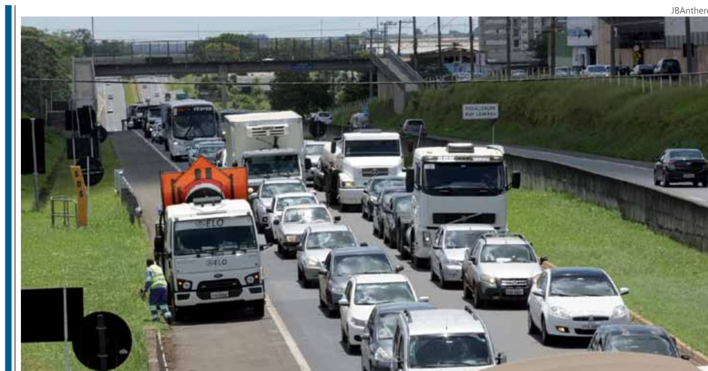
TRÂNSITO PARADO - As obras de implantação de semáforos na rotatória do Cotel/Unicamp estão na fase final. A Intervias termina as intervenções nas calçadas e pinturas. Ontem, o trânsito ficou parado, no início da tarde, no sentido Piracicaba-Limeira, onde era realizada pintura de solo. O trânsito foi desviado para uma única faixa, o que deixou o tráfego mais lento. PÁG. 3
